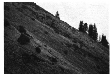
Abb. 4 Die Gleitfläche im obersten Anrissgebiet weist eine Neigung von 30 Grad auf und ist von nachrutschendem Feinmaterial, Boden und Rasenziegeln bedeckt, so dass man nicht erkennt, dass es sich um Nagelfluh handelt.
