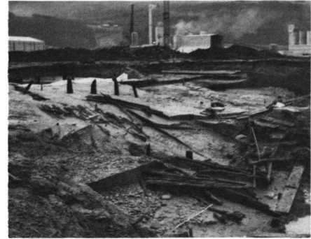
Abb. 2 Thielle Cornaux, Überreste der eingestürzten keltischen Brücke
