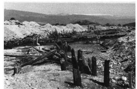
Abb. 6 Uferverbauung an der Zihl aus dem 16. Jahrhundert
