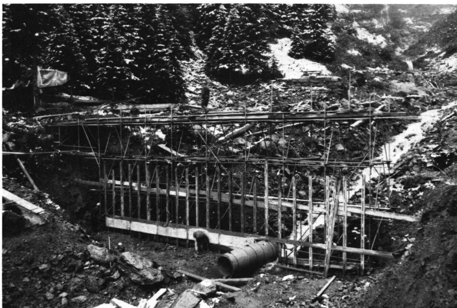
Abb. 2 Wildbachverbauung in Österreich: Auf dieser Baustelle im Simelacherbach (Mölltal, Kärnten) entsteht eine unter vielen Sperrern mit Abmessungen bis zu einer Breite von 30 m und einer Höhe von 6,5 m. Auf dieser Höhe von 1600 m tieft der Bach sehr stark im Moränenschuttmaterial ein, weshalb seine Sohle fixiert werden soll.
