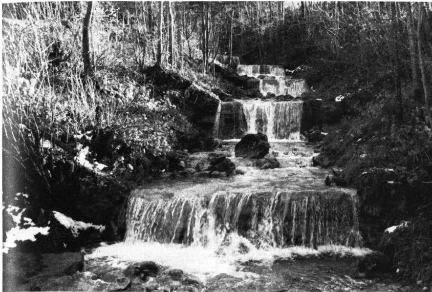
Abb.1 Wildbachverbauung in der Schweiz: Die Verbauung des Eibaches ob Lungern im Kanton Obwalden zeigt zwei Dinge: Eine Wildbachverbauung kann sehr beständig sein (die Sperren in Trockenmauerwerk stammen aus dem letzten Jahrhundert) und daneben optisch trotzdem recht schön aussehen.
