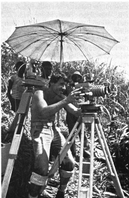
Abb. 3. Landstation am Niger. Das LAWAG wird ausgerichtet.
