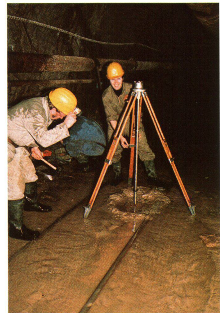
Fig. 2 Assurance des points fixés. Une plaque de laiton ancrée dans la roche au fond du tunnel est dégagée.
