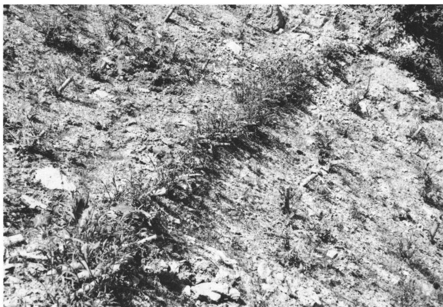
Abb. 5 Hangsicherung Klosters: Steckhölzer, Busch- und Heckenlagen treiben mit dem Beginn der Vegetationsperiode aus. Mit dem Wachstum ihrer Wurzeln steigt die Stabilität der Böschung.
