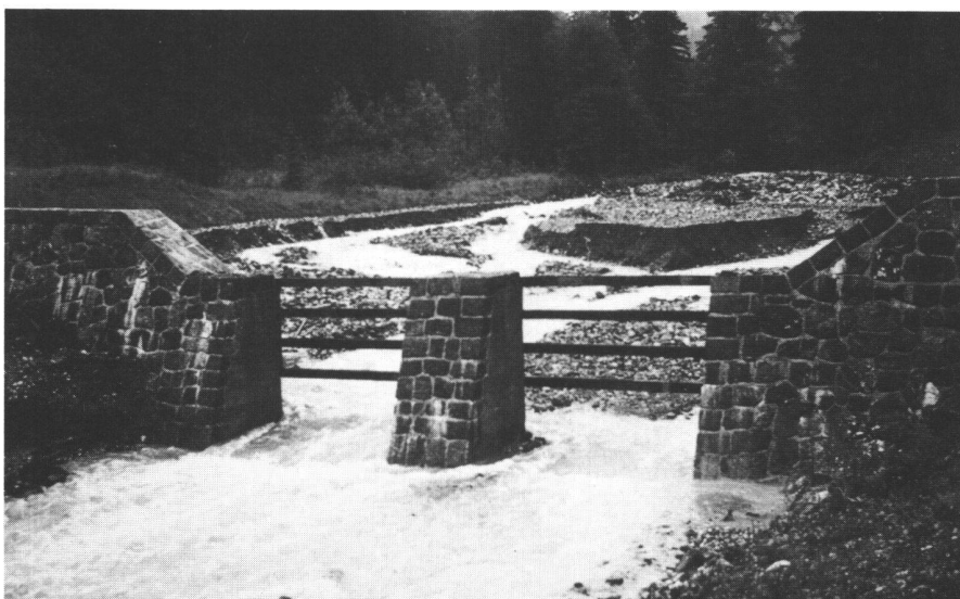
Abb. 7 Geschiebeablageungsplatz Spielbergbach (Fieberbrunn, Kitzbühel, Österreich). Im obersten Bild sieht man das Becken nach seiner Fertigstellung 1972 (Sperrenhöhe 3,2 m), im mittleren Bild den mit 20 000 m 3 gefüllten Ablagerungsplatz im Juni 1975 (Einzugsgebiet 6,9 km 2 , ca. 20- bis 30jähriges Ereignis), und im untersten Bild das Becken nach seiner selbsttätigen Entleerung von ca. 13 000 m 3 innerhalb von vier Wochen nach Beseitigung der Verklausungen an der Rückhaltesperre. (Fotos E. Hanausek, Innsbruck.)
