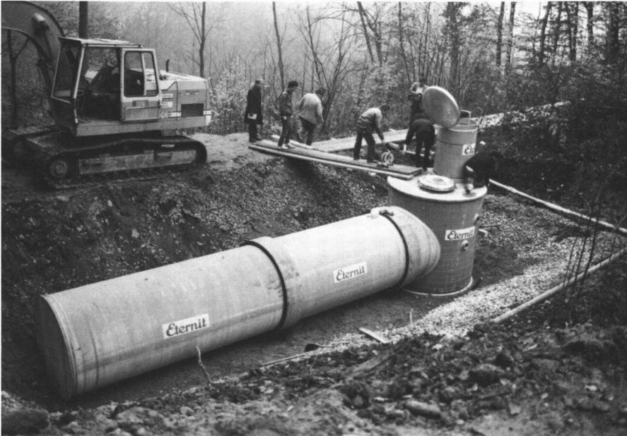
In letzter Zeit war jedoch das qualitativ gute Quellwasser zeitweise von milchiger Farbe. Untersuchungen zeigten, dass die beiden Quellen Wasser von unterschiedlicher Temperatur liefern. Dies führte zu einem Gasüberschuss im Leitungssystem, der sich dem Konsumenten beim Öffnen des Wasserhahns durch ein leichtes Zischen bemerkbar machte. Der Brunnenmeister arbeitete deshalb ein Sanierungsprojekt aus, das vor der Netzzuleitung ein Zwischenreservoir vorsah.
