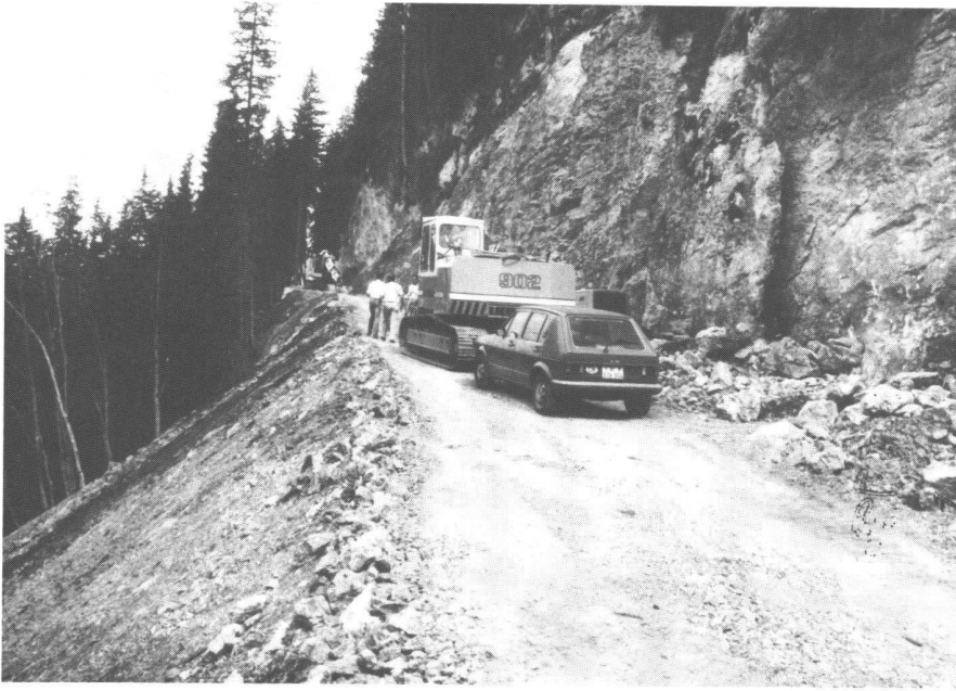
Abb. 5: Wegbau im Grysigswald, ca. 300 m vor dem Tunnel.
