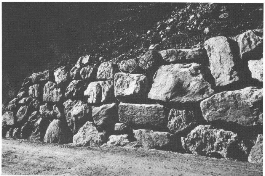
Abb. 6: Blockmauer an der Isenfluhstrasse in Lauterbrunnen.
