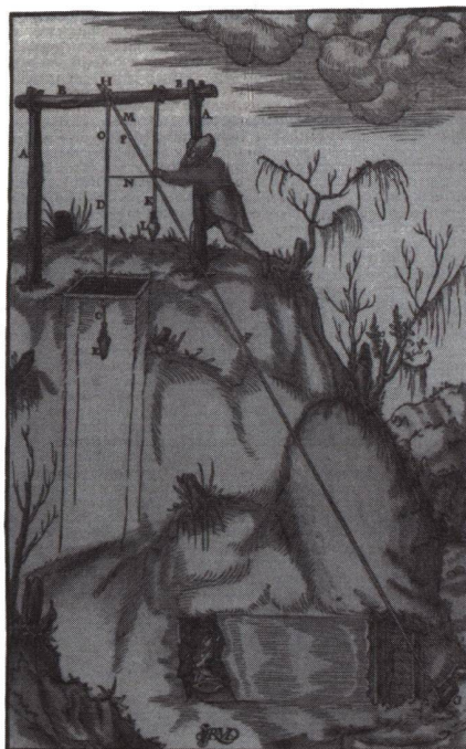
Abb. 1: Markscheiderische Vorausbestimmung der Schachttiefe und Stollenlänge am Durchschlagpunkt von Schacht und Stollen (aus: G. Agricola «De re metallica», Basel 1556).
