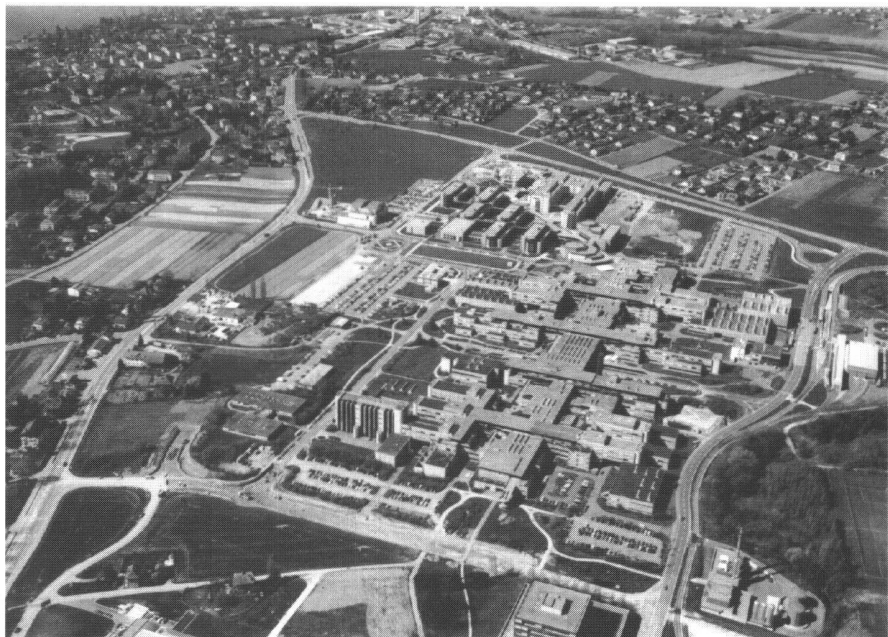
Fig. 1: Vue générale de l'EPFL à Ecublens.
