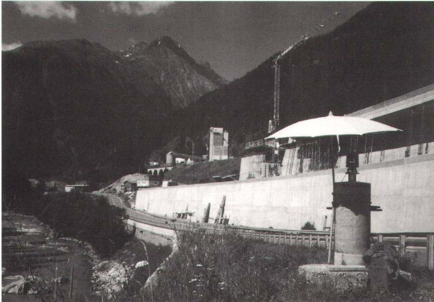
Abb. 8: Teil der Messanlage.
