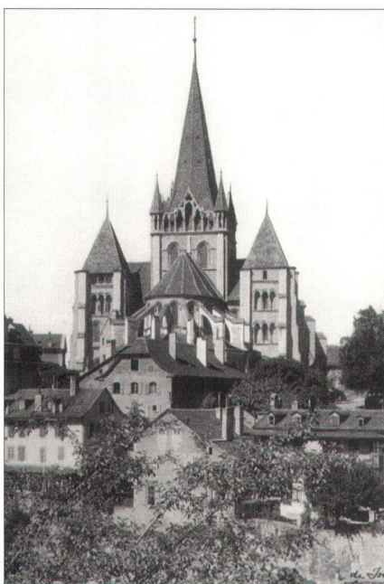
Fig. 1: Vue extérieure de la Tour-lanterne.
