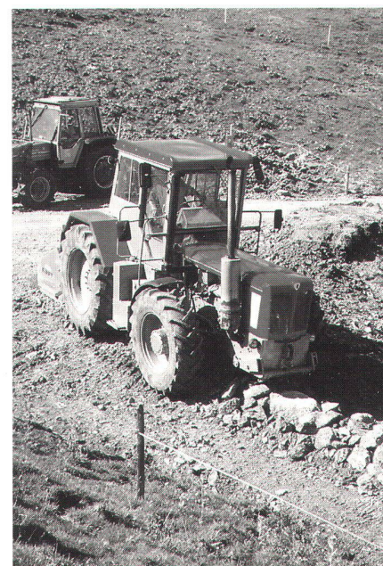
Abb. 2: In ein bis zwei Durchgängen bereitet der traktorgezogene Kirpy das Koffermaterial aus dem Vortrieb an Ort auf. (Foto: F. Walder, Kt. Meliorationsamt SZ).
