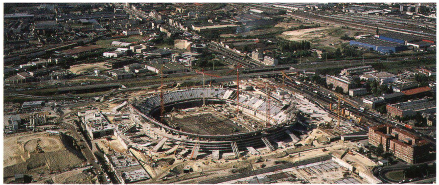
Abb. 10: Die Grossbaustelle im Juni 1996.
