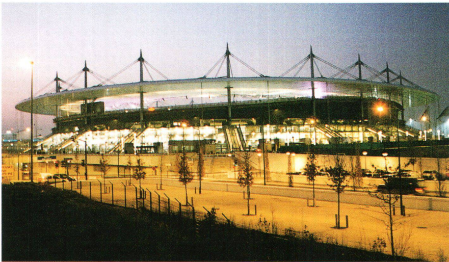
Abb. 1: Sieben Meter unter dem alten Geländeniveau liegt die Arena. Jacques Brottier von der «CIE Stadionbau» schuf ein Festpunktnetz auf Betonpfeilern, eingemessen mit Leica Tachymetern und Leica GPS-Systemen.
