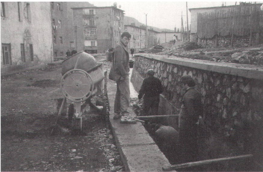
Abb. 3: Baustelle Infrastruktur-Programm: Meteorwasserkanal und Quartierstrasse.
