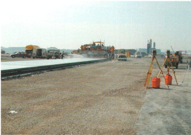
Abb 1: GOMACO Beton-Gleitschalungsfertiger gesteuert durch das Leica Maschinenleitsystem.
