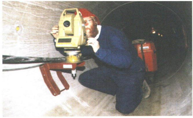
Abb. 9: Vortriebskontrolle im Pressrohr Ø 1,25 m.
