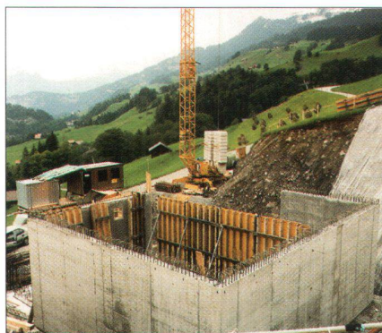
Abb. 7: Das Reservoir Eggli im Bau (Foto: LANA des Kantons Bern, Abt. Strukturverbesserungen).
