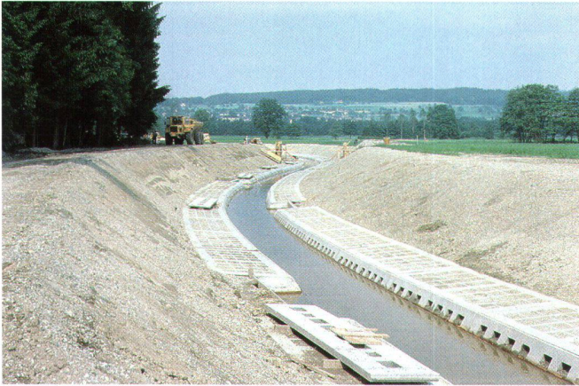
Abb. 1: Bau des Vorflutkanales A5 (1978).
