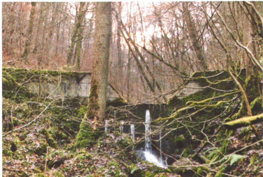
Abb. 1: Massive Betonsperre als Abschlussbauwerk eines Geschiebesammlers am Stutzgraben bei Osterfingen (Kanton Schaffhausen). Solche Geschiebesammler unterbinden jegliche Aufwanderung von Tieren und beeinträchtigen die Bachdynamik entscheidend.
