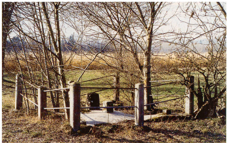
Abb. 7: Heutiger Zustand des Basisendes in Galmiz (Sugiez). Hauptsteine und Versicherungssteine (letztere mit einbetoniert) sind vorhanden und «im Blei». Das umliegende Terrain ist massiv abgesunken (schwarzer Torfboden), vor allem auch die vier mittleren Stützen der Einfriedung. Nicht beurteilbar ist die gesamte Absenkung nach der Juragewässerkorrektur in dieser Gegend. Sie könnte durchaus mehr als einen Meter betragen.
