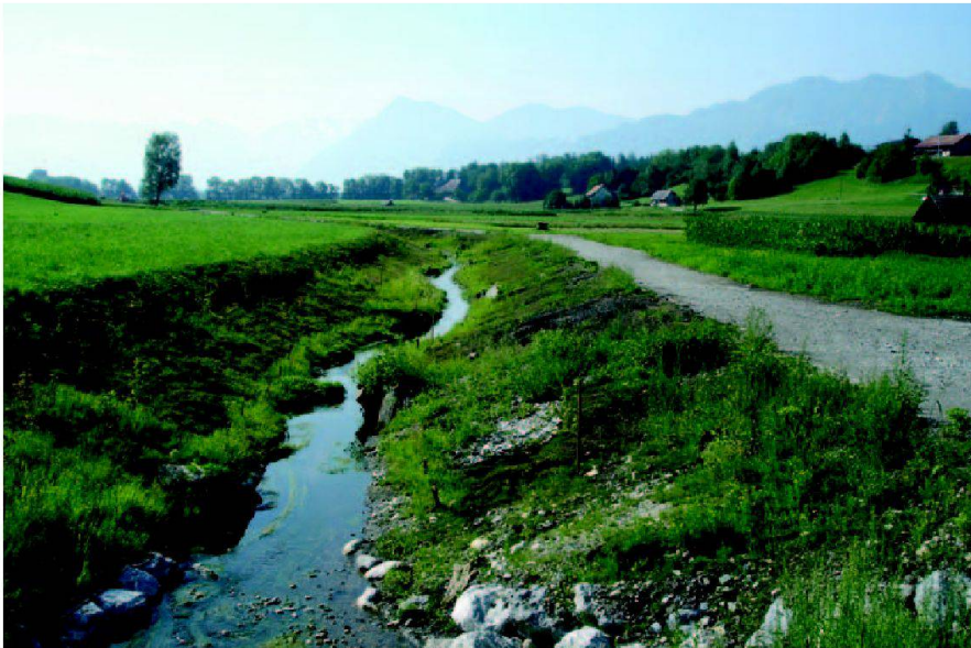
Abb. 2: Nach der Renaturierung: Der neue Limpach (Kronenbreite 12 m, Gefälle 1.2 Promille) mit Uferweg, die neu gesetzten Hecken sind noch schlecht sichtbar.
