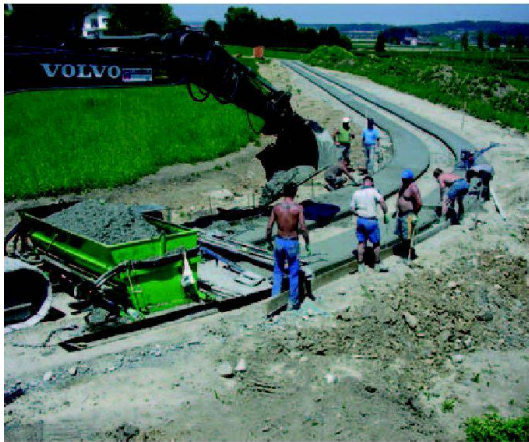
Abb. 4: Einbau Betonspuren im Bereich des Wildtierkorridors.
