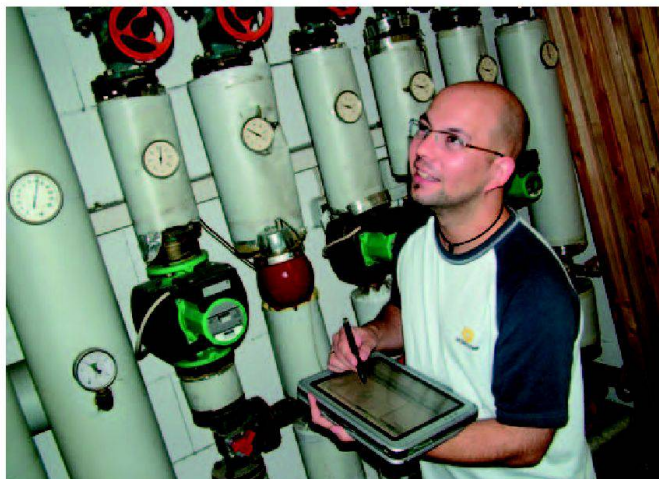
Mobiler Arbeitsplatz LIDS iView bei der Kellerbegehung.
