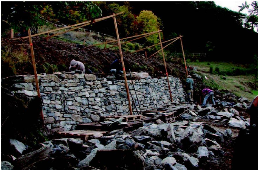
Abb. 3: Trockenmauer wird wieder aufgebaut.
