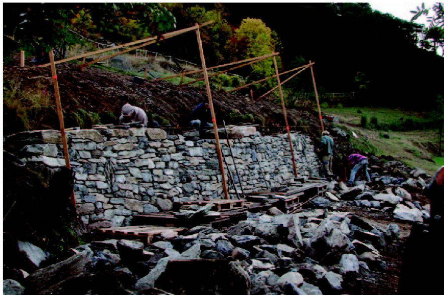
Abb. 3: Trockenmauer wird wieder aufgebaut.
