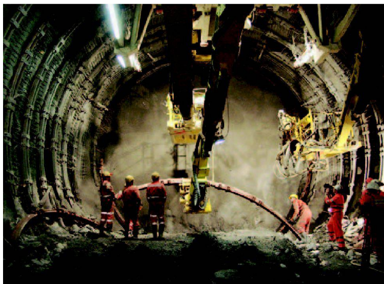
Abb. 6: Stahleinbau Sedrun.
