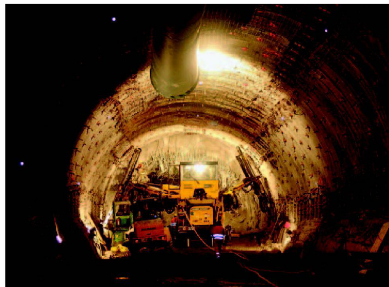
Abb. 7: Überfirstung Faido Weströhre.
