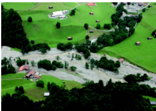
Abb. 6: GR Klosters: Kulturlandverlust; zerstörte Gebäude und Güterwege.
