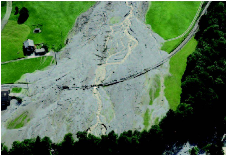
Abb. 4: OW Engelberg: Bachlauf mit übersaartem Kulturland und zerstörten Verkehrswegen.
