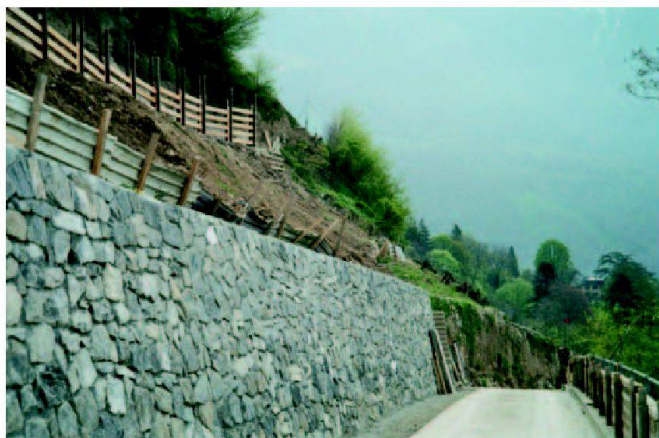
Fig. 3: Chemin de base avec consolidation des sols.
