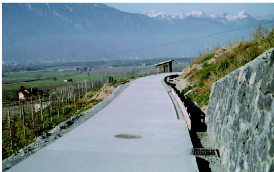
Fig. 5: Une infrastructure adéquate.
