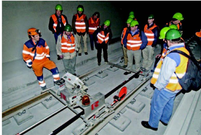
Lage und Höhe (innere Verlegegenauigkeit) des frisch einbetonierten Gleises. Stellt der Messwagen eine Abweichung zu den Toleranzwerten fest, meldet er diese über eine Warnblinkleuchte.
