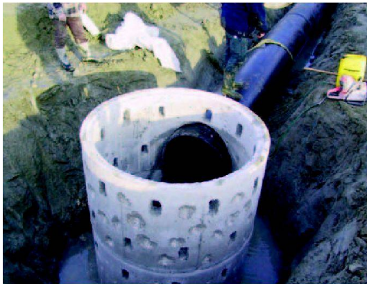
Fig. 2: Exécution de la prise d'eau d'arrosage dans le lac de Neuchâtel.
