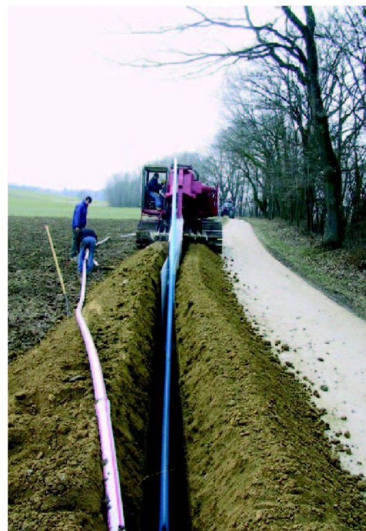
Fig. 4: Pose à la trancheuse des tuyaux de refoulement.
