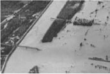
Abb. 6: Beispiel eines Dammbrechtes am Alpenrhein beim Hochwasser 1927. Weil der Damm brach, floss praktisch der ganze Alpenrhein aus.
