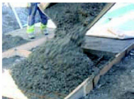
Fig. 3: Comme ici à Scheid (GR), les treillis d'armature protègent le béton contre les contraintes de traction et réduisent les quantités de béton à transporter.
