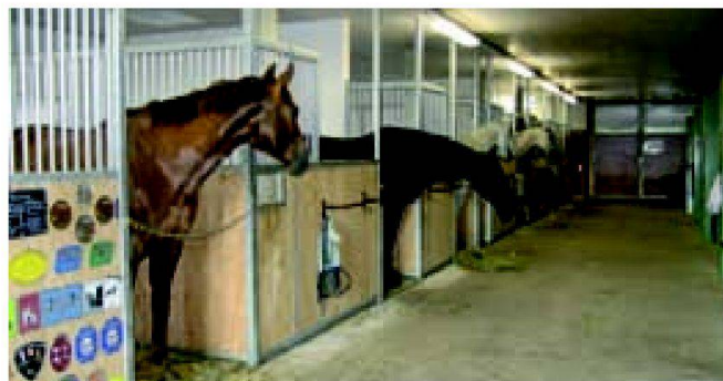
Abb. 2: Gelungene Betriebsumstellung von Milchviehhaltung auf Pferdepenion. Elf Einzelboxen und zwei Doppelboxen, alle mit Auslauf, in den ehemaligen Milchvieh- und Mastviehställen. Ausserdem wurde ein Pferde-Ausbildungsplatz (20 x 38 m) mit Longierzirkel und einer Pferdeführung errichtet.
