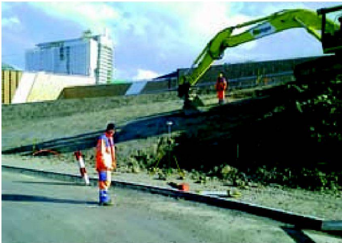
Abb. 5: Trimble 5800 GPS Receiver im Einsatz.
