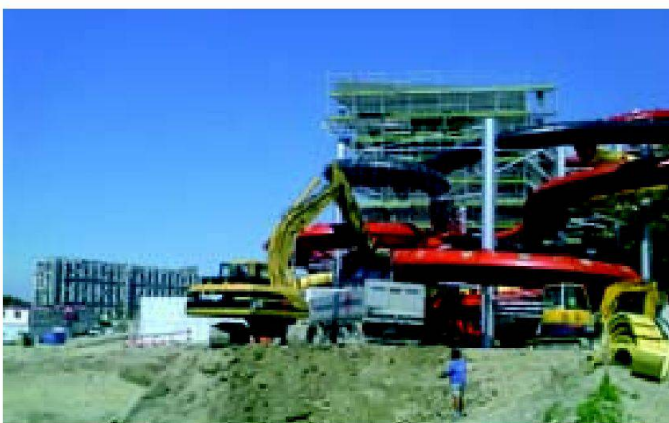
Abb. 7: Geländeabsteckung vor der Wasserrutschbahn.
