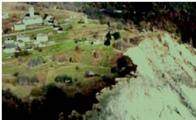
Abb. 10: Stabilisierte Rutschmasse im Valle di Campo TI.
