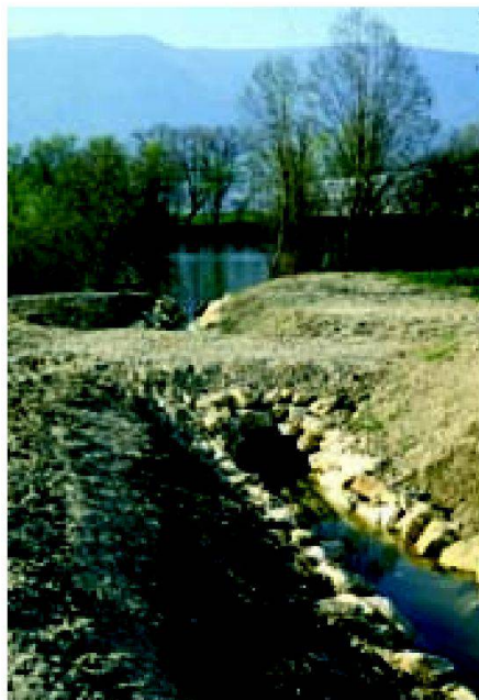
Abb. 3: Gemeinde Arch: Im Rahmen der Gesamtmelioration renaturierter Dorfbach nahe der Einmündung in die Aare kurz nach der Fertigstellung (1996).
