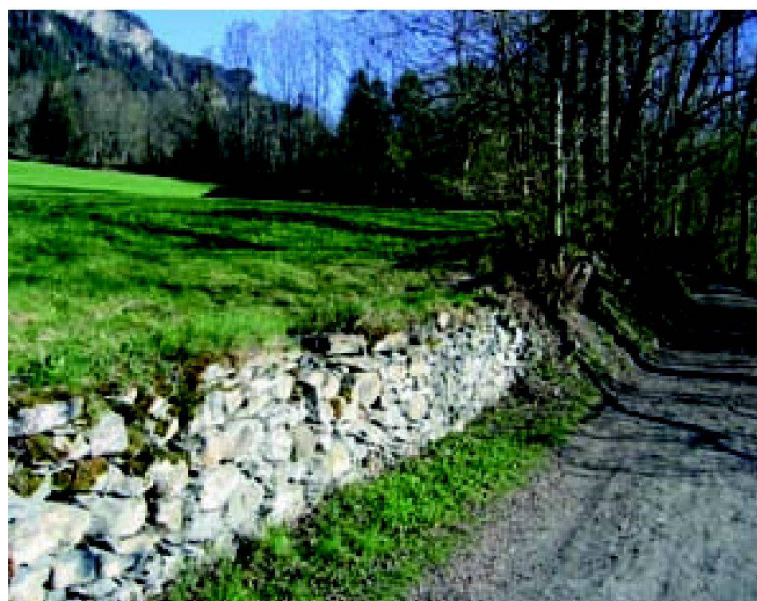
Abb. 3: Die klassische primäre Mehrfachfunktion der Trockenmauer: Stützen, Terrassenbildung, Abgrenzung, Linearelement entlang Weganlage (Gemeinde Almens).
