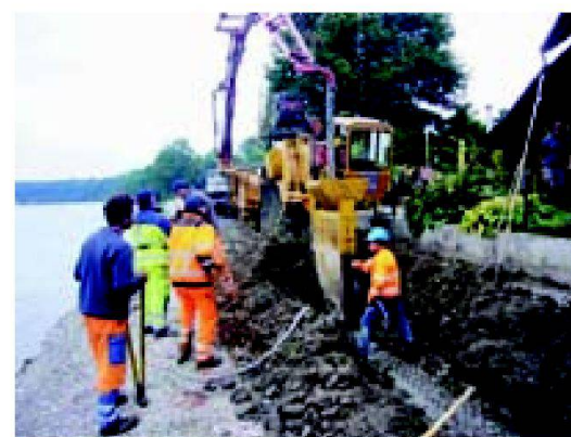
Abb. 4: Bau einer Betondichtwand.
