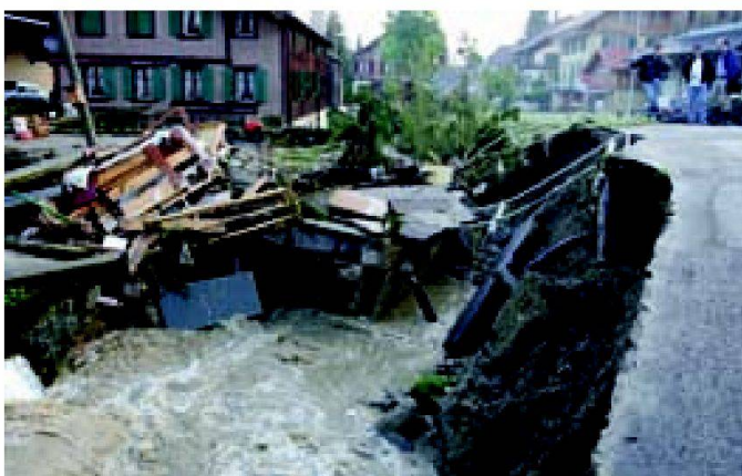
Abb. 1: Die Gewalt eines kleinen Baches: Die Langete in Eriswil BE nach dem Hochwasser im Juni 2007. Eine Person starb, es entstanden Schäden in Millionenhöhe (Foto: Marcel Bieri).
