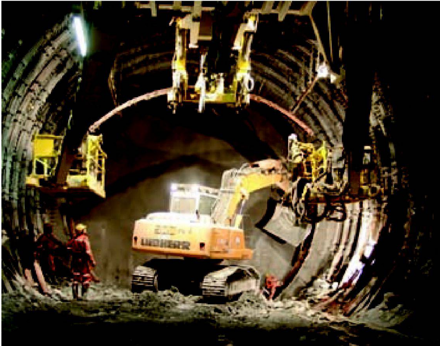
Abb. 2: Im Teilabschnitt Sedrun wurden zur Felssicherung flexible Stahlbogen eingebaut.
