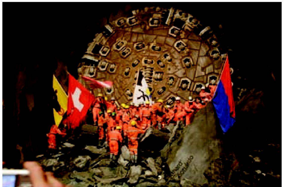
Abb. 3: Weltrekord am Gotthard: Am 15. Oktober 2010 feierten die Mineure in der Oströhre den Hauptdurchschlag im Gotthard-Basistunnel.
