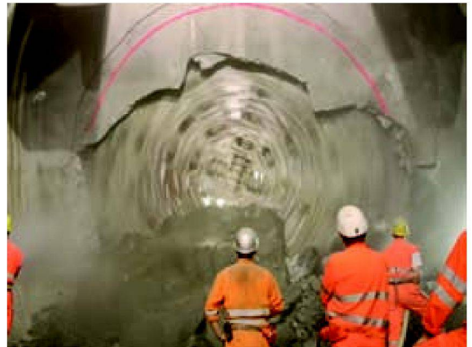
Abb. 12: Bohrkopf der Tunnelbohrmaschine im Moment des Durchschlags.
