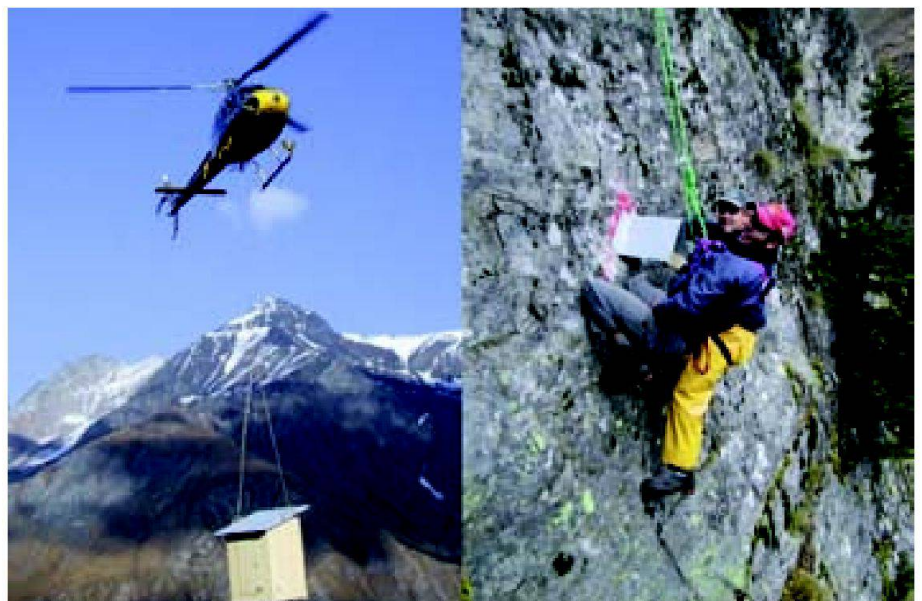
Abb. 3: Impressionen der Montagearbeiten.
