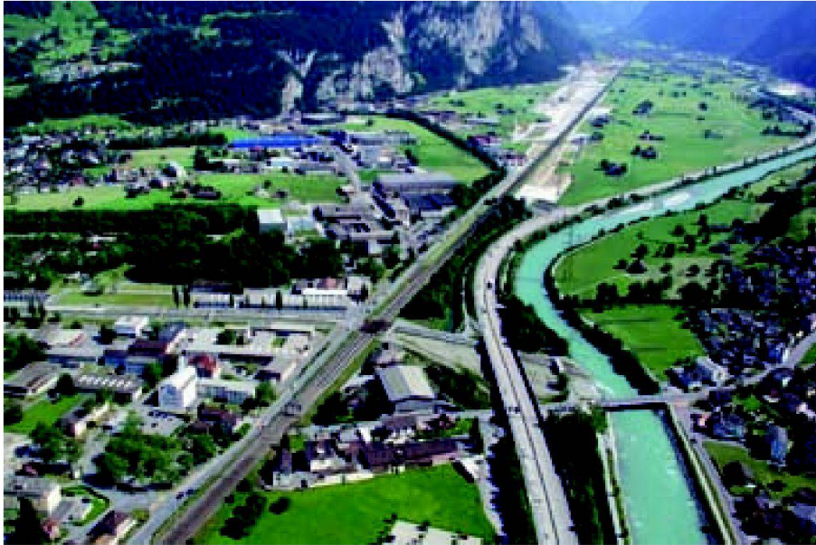
Abb. 1: Übersicht Baustelle Altdorf/Rynächt bis Teilabschnitt Erstfeld.
