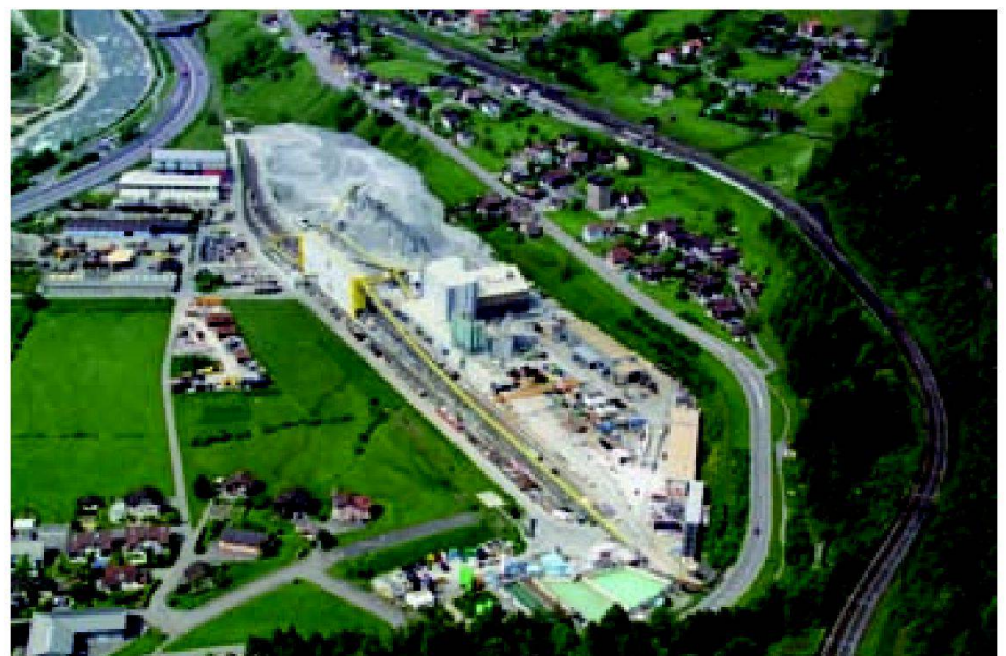
Abb. 2: Übersicht Aussenanlagen und Zugangsstollen Teilabschnitt Amsteg.
