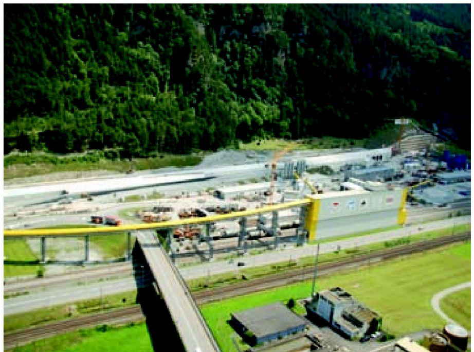
Abb. 1: Der Portalbereich bei Erstfeld: Die Bohrpfahlwand rechts sichert den Hangbereich unmittelbar vor dem bergmännischen Tunnelportal, links davon ist bereits der Tagbautunnel erstellt. Förderbänder und der Installationsplatz umgeben die Baustelle (Foto: AlpTransit Gotthard AG, Adrian Wildbolz).
