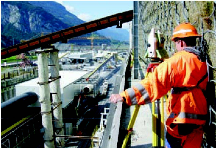
Abb. 4: Geodätische Vermessung auf der Bohrpfahlwand (Foto: Basler & Hofmann).
