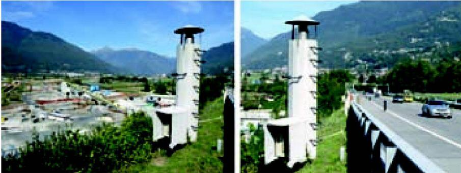
Abb. 2: Messpfeiler: Automatische Überwachung entlang der Autobahn A2 – das Monitoringsystem detektiert Bewegungen mit einer vorgegebenen Sensitivität von 3 mm.
