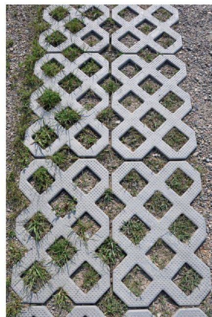
Abb. 2: Detail der Rasengittersteine aus Kunststoff-Recycling. Fig. 2: Détail des pavés ajourés en plastique recyclé.
