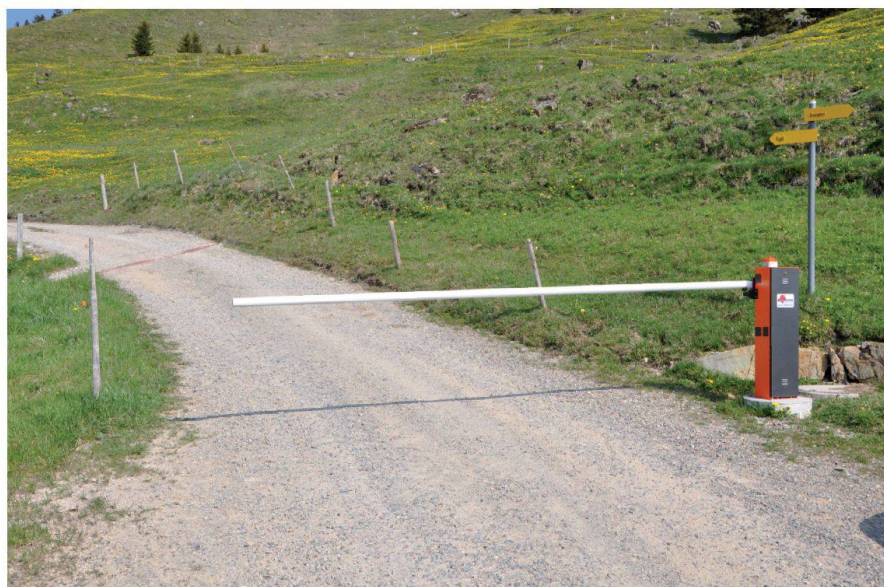
Fig. 4: Une barrière automatique empêche l'utilisation non autorisée du chemin d'alpage.
