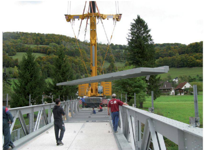
Fig. 5: Montage du nouveau tablier (grue avec élément de tablier).
