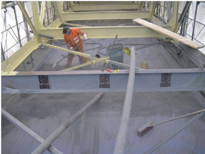
Fig. 4: Travaux de sablage.
