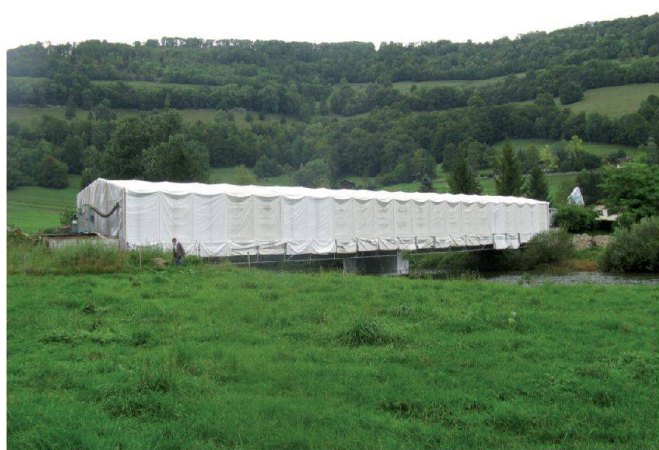
Fig. 2: Confinement pendant le chantier.
